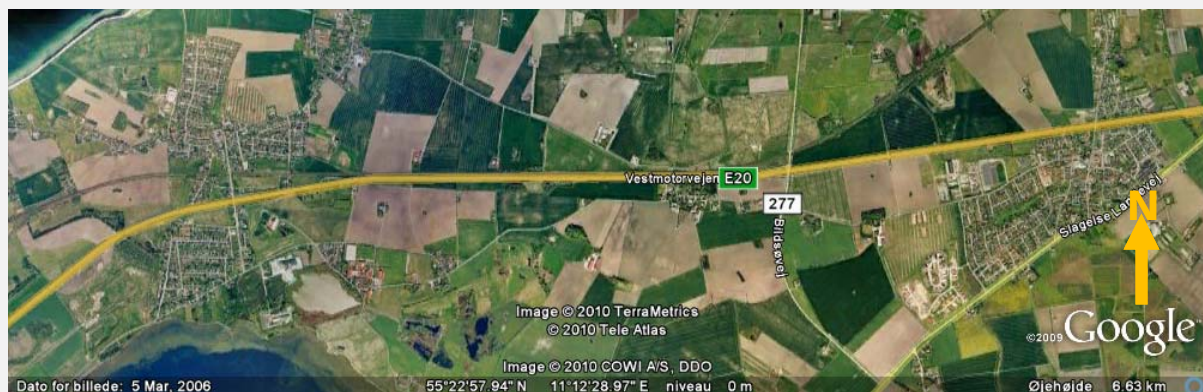
Figur 47. Udsnit af en af de ældste danske motorveje, nemlig E20 – Vestmotorvejen mellem Halsskov (Korsør) og Slagelse. Strækningen er opbygget af rette linjestykker, hvorimellem der er indlagt kurver med forholdsvis små horisontalradier. Billede fra Google Earth.
